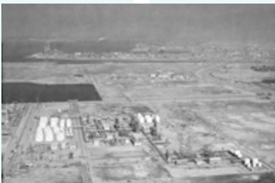
日産石油化学千葉工場(1968年頃)
